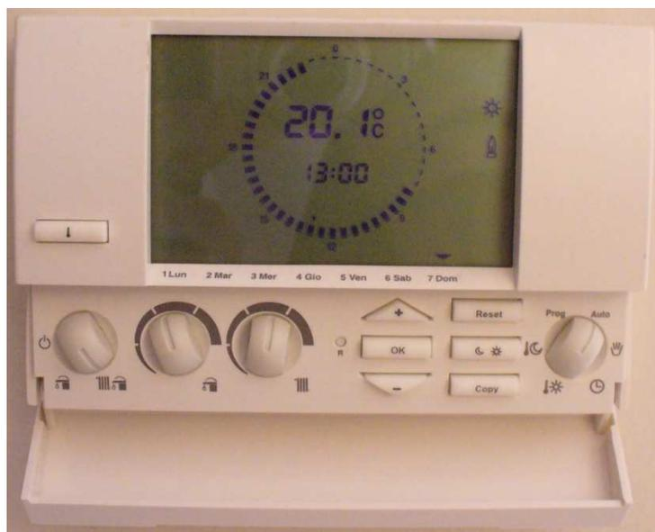
**Foto 10: Termostato per la regolazione della temperatura ambientale**
