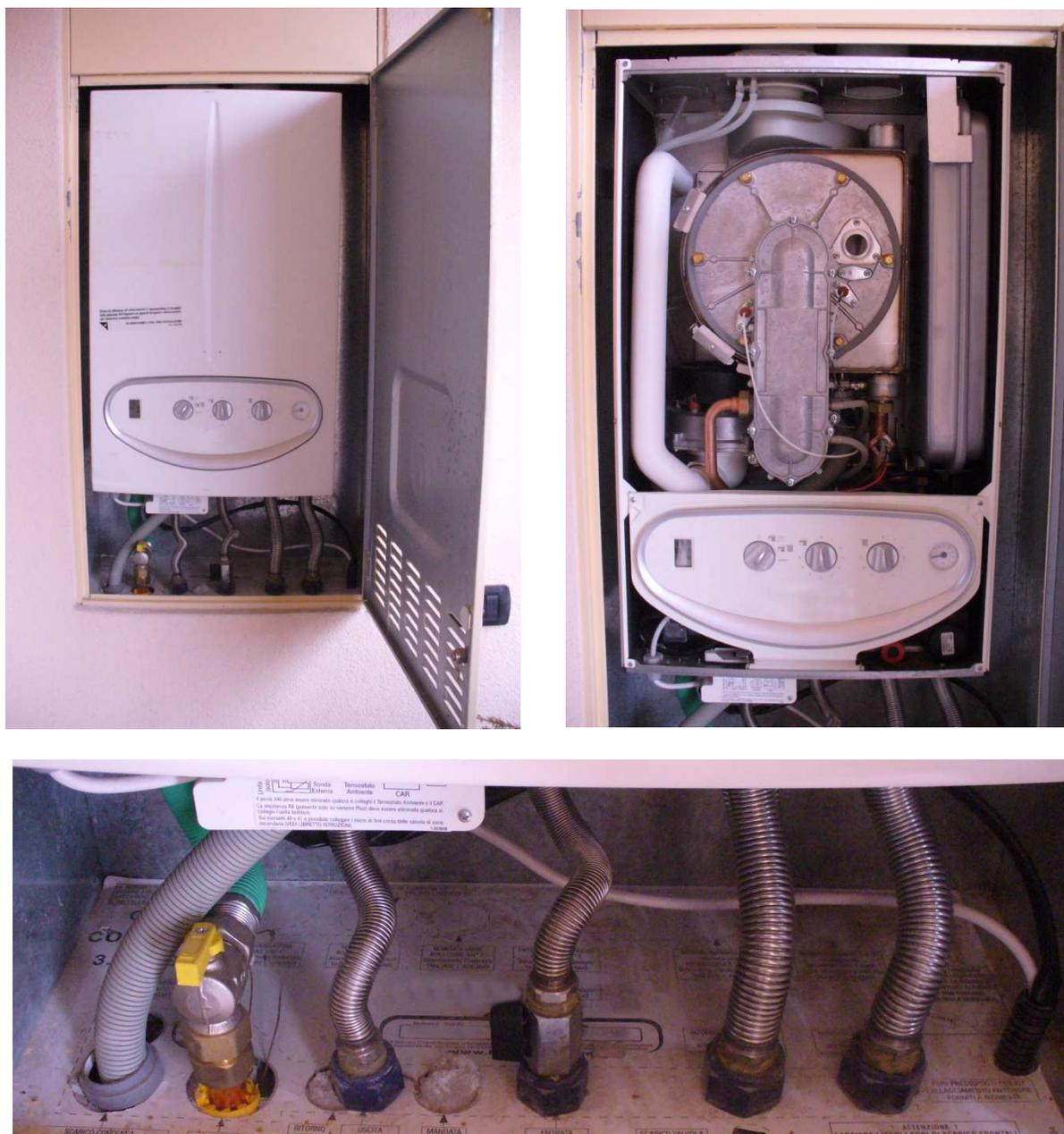
Foto 8: Caldaia esterna, vano tecnico e connessioni idrauliche.
